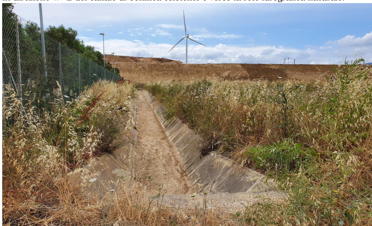
Figura 31: canale di raccolta e drenaggio superficiale delle acque sul lato est del lotto a ridosso del canile
